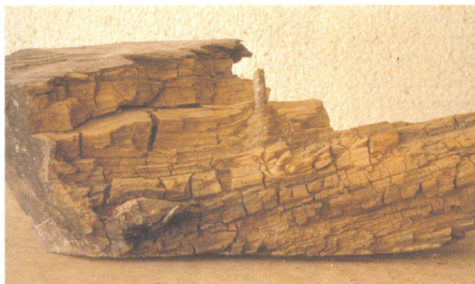
Figura 1.1 Daños producidos por hongos de pudrición parda.
