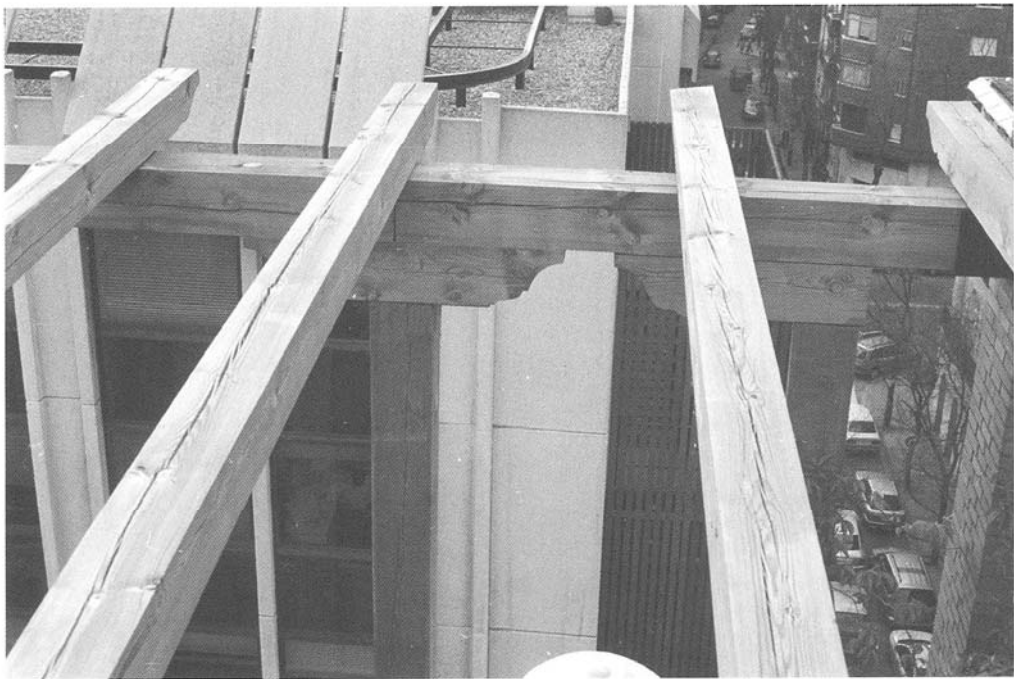
Figura 1.10 Alabeo de las piezas después del secado.
