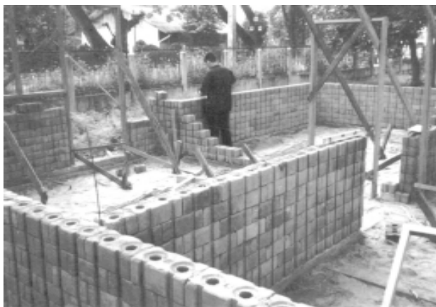
7-11 Bloques machihembrados (Weinhuber 1995)
