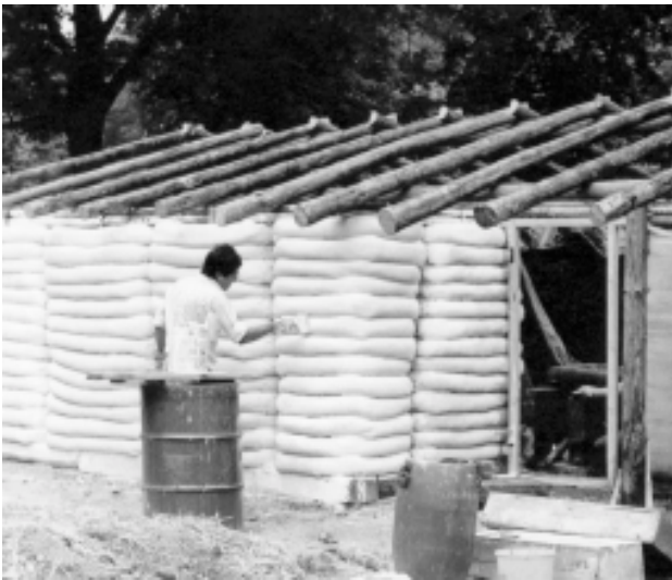
9-2 y 9-3 Muro de mangueras textiles rellenas
