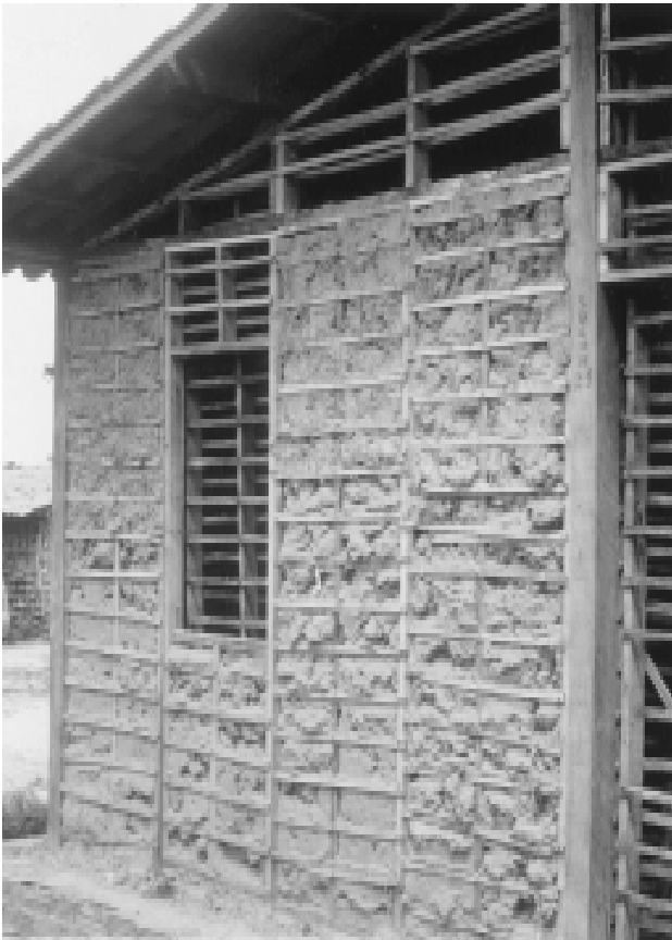
8-3 Bahareque con elementos prefabricados CEPED, Brasil
