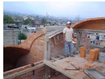
*Trabe combinada (curva de concreto y trabe metálica inclinada).*
