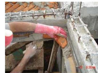
*La segunda hilada de ladrillos, se apoya en la hilada anterior. Se insinúa un arco cortando las esquinas de los ladrillos.*
