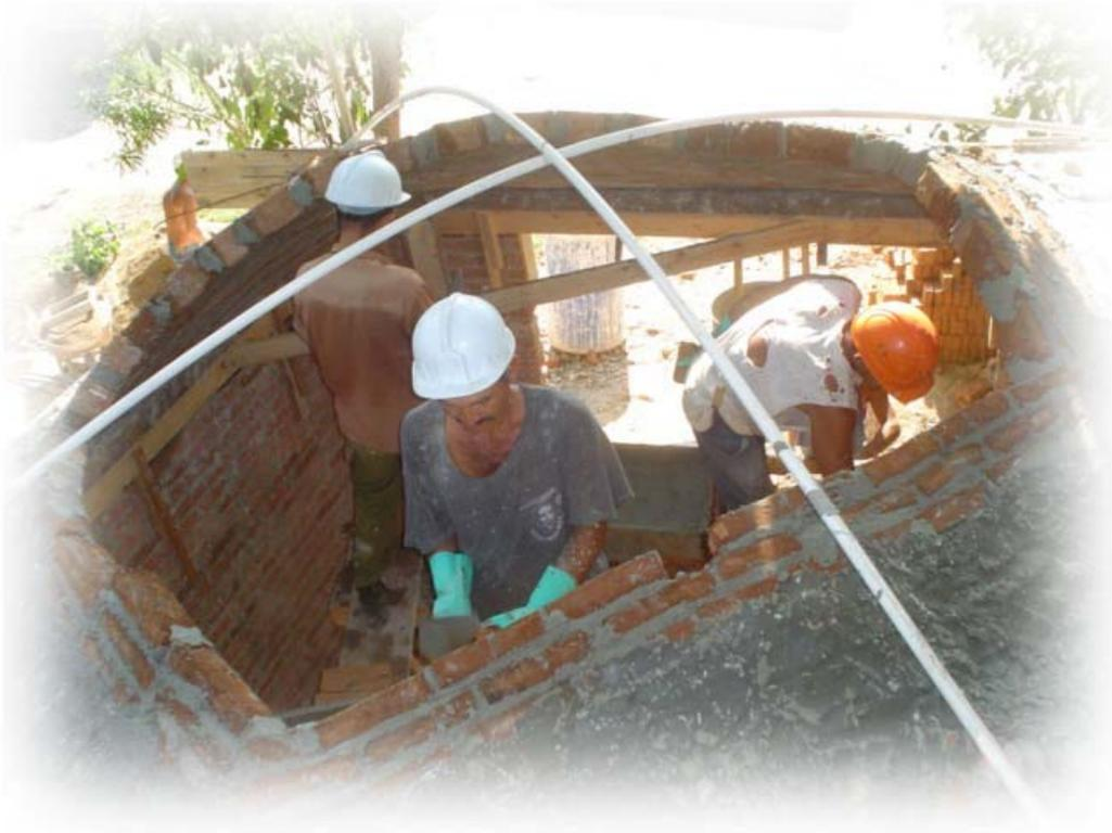
*Las bóvedas mexicanas son un sistema de construcción tradicional en México, basado en la utilización del ladrillo en forma de arco y soportado por su propio peso.*
