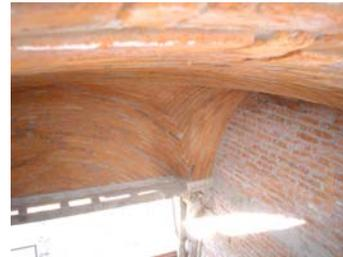
*Trabe combinada (concreto ondulado con ranura en muro de ladrillo).*
