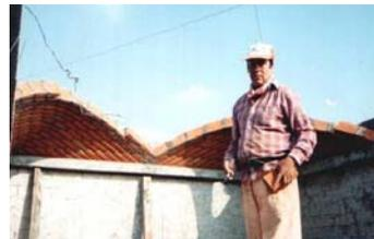
*Terminadas las cuatro esquinas se coloca una hilada en cada cono (pechina) en forma de espiral, hasta casi cerrar la bóveda.*
