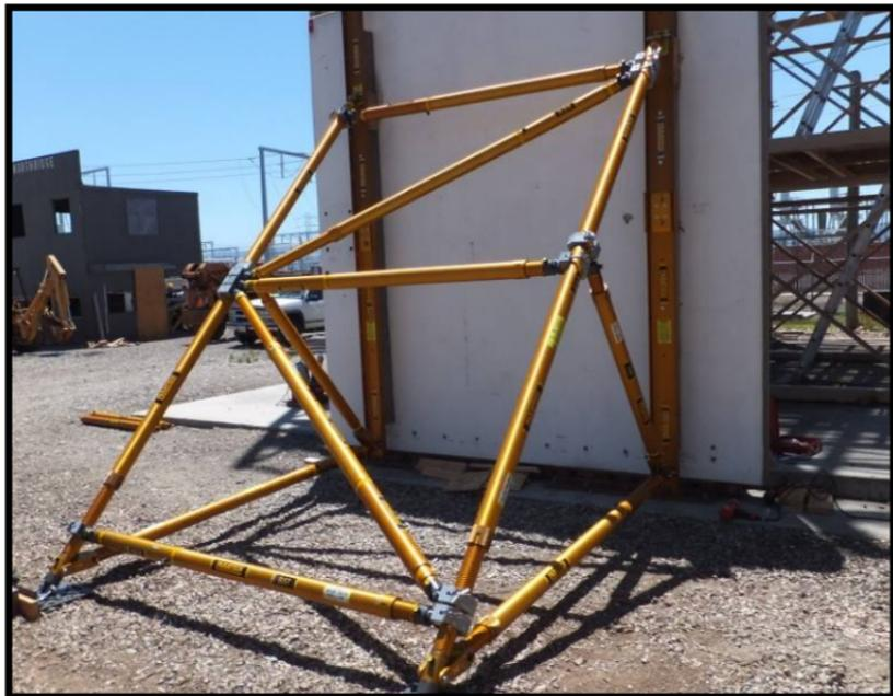
**PUNTAL INCLINADO CON BARRAS AMORTIGUADORAS EN TRIÁNGULO ENTERO - TODAS LAS BRARAS AMORTIGUADORAS**
