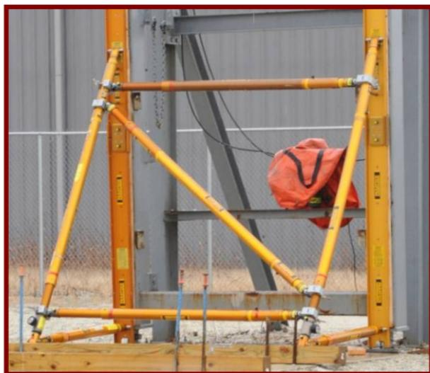
Foto del puntal inclinado usando arriostamiento con barra amortiguadora - no es necesario que sea de madera
