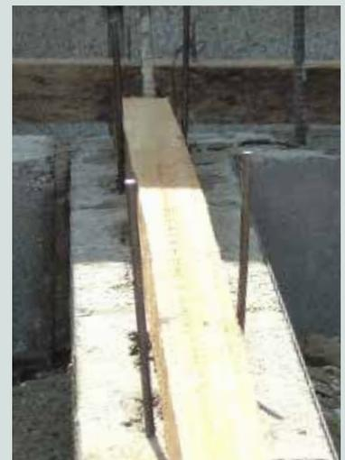
Varillas de acero para conectar un panel de pared
