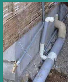
**4** Conexión entre tuberías de 2" y 4"
