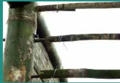
Anclajes a un solo lado en cañas en la extremidad de la pared
