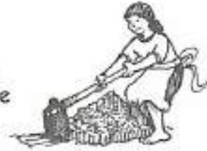
Personas conocedoras del tema sostienen que es suficiente con que las paredes guarden la proporción de 3 x 1 y que el adobe sea estabilizado con una pequeña cantidad de cemento, que puede ser desde 6 partes de tierra por 1 de cemento, hasta 10 partes de tierra por 1 de cemento. La cantidad adecuada de cemento depende lógicamente de la calidad de tierra con que se construye. Como solera se propone cuartón o madera rolliza adherida con pequeños durmientes de madera empotrados en la pared.
