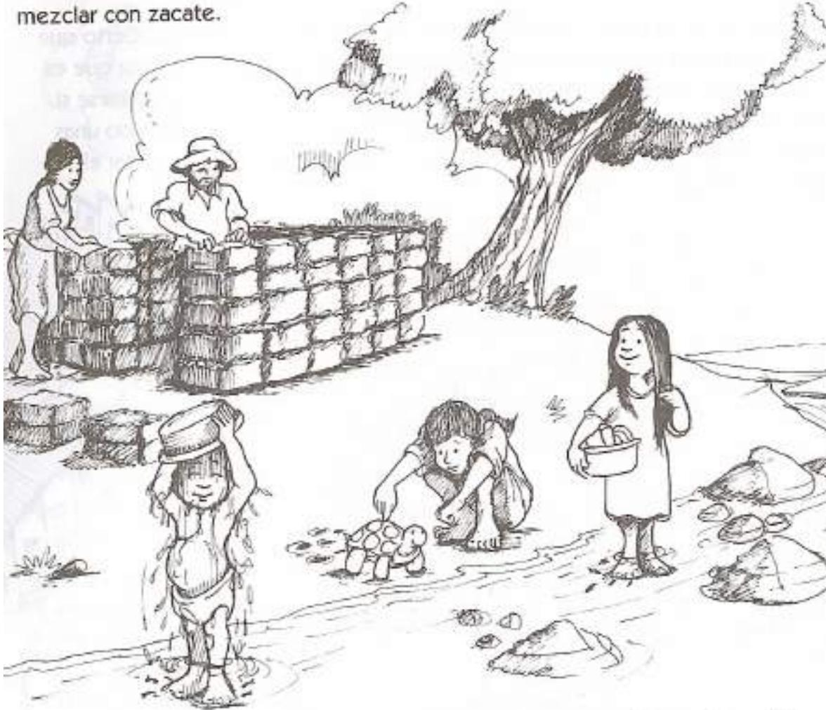
Podemos decir que tanto la elaboración del adobe como la construcción de la casa se hace con una técnica "empírica". Con el tiempo, las paredes de las casas construidas con esta clase de adobe, se deterioran y quedan debilitadas y expuestas a la destrucción por los terremotos y otras causas.
