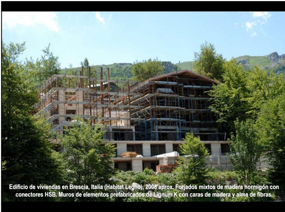
Edificio de viviendas en Brescia, Italia (Habitat Legno), 2008 aprox. Forjados mixtos de madera hormigón con conectores HSB. Muros de elementos prefabricados de Lignum K con caras de madera y alma de fibras.
