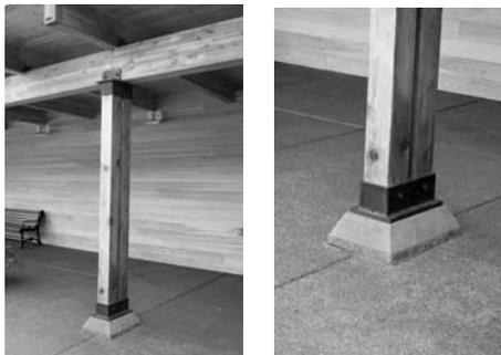
Pie derecho de madera maciza con un apoyo sobre una basa de piedra a través de un herraje de acero que encierra la pieza. El herraje no permite la ventilación de la madera en caso de entrada de agua al interior, aunque el alero puede llegar a impedir la llegada del agua de lluvia.
