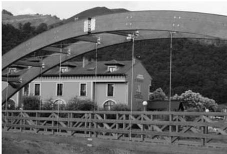
Clave articulada de los arcos de una pasarela realizada con herrajes exteriores con chapa galvanizada. La cara superior del arco se encuentra protegida con una albardilla metálica y la madera está tratada en profundidad.
