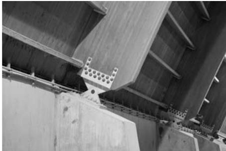
Articulación en el apoyo de un arco de gran luz (80 m aprox.). Puede observarse como la superficie de apoyo es menor que la sección del arco. Los pernos deben dimensionarse para resistir el cortante, la succión en su caso, y alguna norma indicaba que debería asumir al menos el 50 % del axil de compresión.
