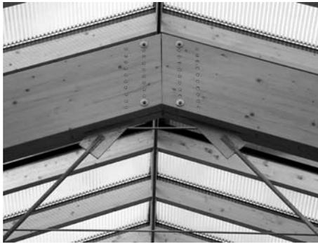
La articulación de la clave se realiza mediante un herraje oculto que consiste en una chapa interior que sirve de arranque a los tirantes y se une a la madera mediante pasadores. Cuatro de los pasadores se sustituyen por pernos para afianzar la unión.
