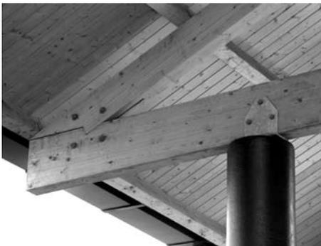
Nudo de encuentro entre un par y un tirante mediante un ensamble tradicional de embarbillado de talón. Sin embargo, en el interior se ha dispuesto una chapa de acero que se conecta con cuatro pernos. Posiblemente, el herraje sea sólo para afianzar la unión y resistir alguna tracción.
