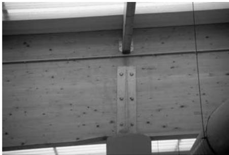
Apoyo de una viga pasante sobre un pilar de hormigón armado. La viga tiene una ligera pendiente, pero el plano de apoyo se desarrolla en horizontal con el fin de transmitir las cargas gravitatorias sin empujes horizontales. Los tirafondos que unen las chapas a la madera deben ser capaces de resistir los esfuerzos de succión.
