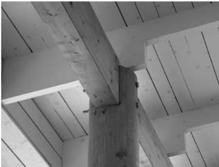
Pilar de madera laminada encolada de sección circular sobre el que apoya una viga de madera laminada encolada de sección rectangular. Un cajeado en la cabeza del soporte deja el paso libre a la viga continua que se asegura con dos pernos.
