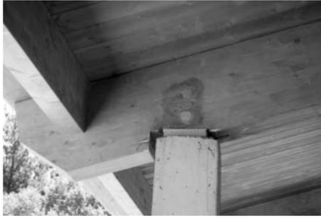
Apoyo de un par de cubierta sobre un pilar de hormigón. La chapa de asiento anclada en la testa del pilar de hormigón lleva una chapa soldada que se aloja en el interior de la pieza de madera. Dos pernos cosen la pieza de madera con la chapa interior. Las cabezas de los pernos se han ocultado con tapones de madera encolados. La base del apoyo del par es horizontal.
