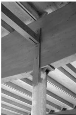
La barra horizontal que acomete a la cara de la viga sirve de elemento de estabilización del encuentro evitando la tendencia al giro del apoyo.
