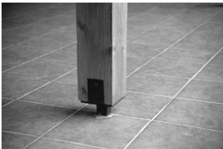
Pie derecho de madera maciza que descansa sobre una pieza metálica que lo separa del suelo. La carga se transmite a través de una chapa de asiento en la base, con dimensiones ligeramente inferiores a la sección del pilar. Las chapas laterales sirven para afianzar la unión mediante un perno. Este permitiría resistir cierto esfuerzo de tracción en caso de succión del viento.
