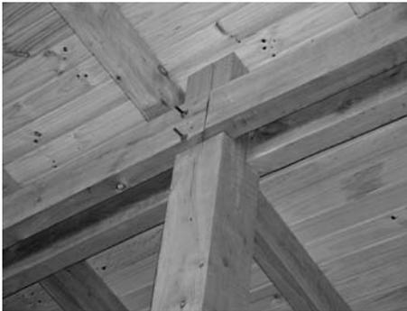
Encuentro entre pilar y viga pasantes. El pilar presenta dos cajas laterales que reducen la sección localmente pero sirven de apoyo a las dos piezas que forman la viga. La unión se afianza con dos pernos. Las vigas compuestas por dos piezas más delgadas presentan esta cómoda forma de unir, pero también se reduce su eficacia frente al caso de incendio al reducir su anchura, ya que ambas piezas presentan las cuatro caras expuestas.
