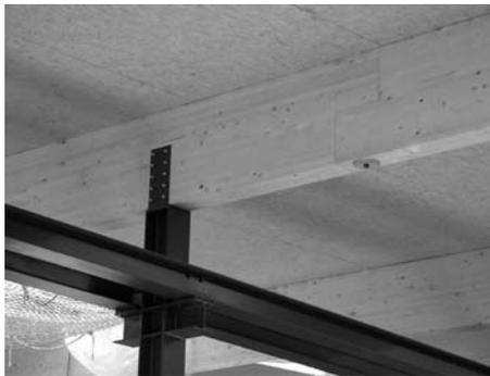
Empalme articulado de una viga continua (junta Gerber) realizado con un simple encuentro a media madera invertido, de manera que la viga de la derecha se cuelga del voladizo de la izquierda mediante un perno que dispone de una arandela (placa de reparto) en la cara inferior y superior.
