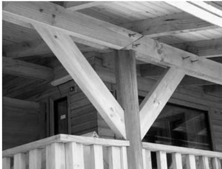
Encuentro entre un pilar de rollizo y una viga de madera aserrada pasante y formada por dos piezas. El apoyo se realiza mediante rebajes en la sección del poste y se afianzan con dos pernos. Las tornapuntas aportan rigidez en el plano del pórtico y disminuyen la flexión en la viga.
