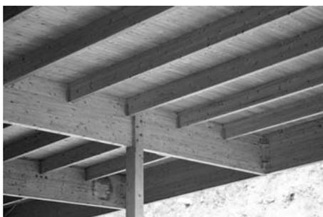
El pilar de madera laminada encolada presenta en el extremo superior un hueco central donde se aloja la viga pasante a la que se une con cuatro pernos. Las cargas gravitatorias se transmiten por compresión en la superficie de apoyo, mientras que los pernos deben asumir los esfuerzos negativos debidos a la succión del viento.
