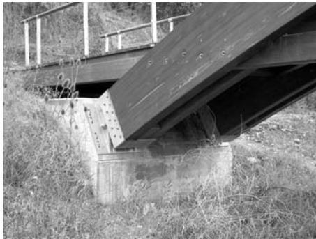
En estos casos es necesario la utilización de madera tratada en profundidad para clase de uso 4, y es recomendable dejar en la testa de la madera zonas sin chapa para permitir cierta ventilación. Debe observarse que la cara superior de los arcos no tiene un elementos de protección frente al agua de lluvia
