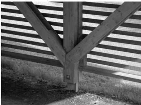
El pie derecho de esta estructura de una cubierta de aparcamiento está formado por dos piezas de madera con una separación entre sí donde se aloja una lengüeta de tablero. Su apoyo en el suelo se realiza a través de una chapa de acero inoxidable de igual espesor a la separación entre perfiles, para evitar el contacto con el suelo.
