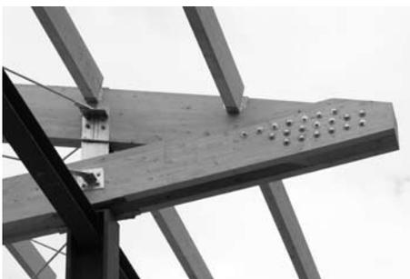
Encuentro entre un par simple que queda encepado por el tirante doble y que se conectan mediante pernos que trabajan a doble cortadura. El centro de gravedad de los pernos es coincidente con los ejes de las piezas.
