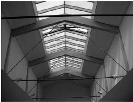
Pórtico de madera laminada encolada formado por dos pilares biarticulados y un dintel que se encuentra también articulado en la clave. Los dos tirantes metálicos en diagonal aportan la estabilidad al conjunto. Otro tirante horizontal resiste el empuje horizontal en los apoyos.
