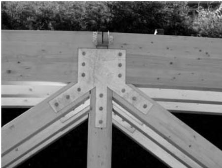
Nudo de una celosía donde se encuentran cuatro piezas de madera laminada encolada con dos chapas exteriores y pernos de conexión.
