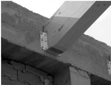
Apoyo de una correa sobre una viga de hormigón armado. El herraje es similar al normal, pero la conexión al hormigón se efectúa mediante tornillos con tacos.
