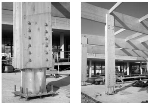
Pilar de madera laminada encolada compuesto por dos cordones, que se encuentra empotrado en la base y su cabeza está articulada donde descansa una viga continua. El herraje del apoyo separa la madera del suelo y aloja un perfil de sección tubular rectangular que es cosido con las dos líneas de pernos que transmiten el momento flector.
