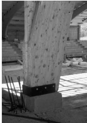
Apoyo articulado de un semipórtico o arco de madera laminada que se ha realizado con lo que se suele denominar articulación ficticia. El herraje que abraza la pieza de madera queda anclado al hormigón sólo en la parte central, para no coartar completamente el giro.
