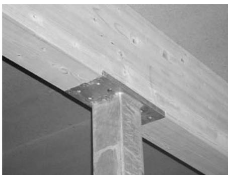
Apoyo de sencillo diseño de una viga de madera laminada sobre un pilar metálico de tubo cuadrado hueco. La chapa de testa del pilar sirve de zapata que aumenta la superficie sometida a compresión perpendicular a la fibra. La fijación se realiza mediante 8 tirafondos.
