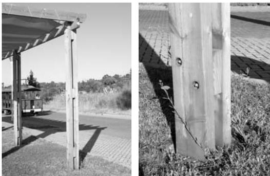
Pilar empotrado o en contacto con el suelo, que requiere un tratamiento químico en profundidad. El pilar está compuesto por dos cordones con separadores fijados con pernos. La vida útil de la estructura queda limitada a la vida de la madera tratada en contacto con el suelo (10 a 20 años).
