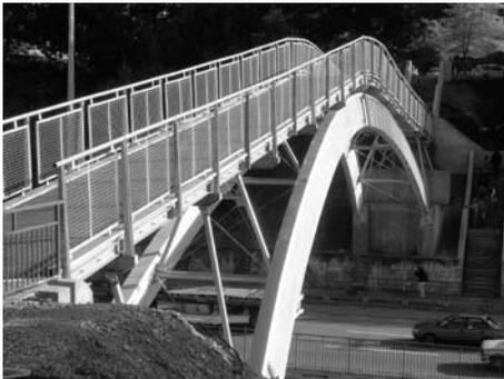
Arranque de un arco triarticulado de una pasarela. La unión se materializa con un bulón de giro libre entre las orejas de chapa de acero. El herraje abraza a la pieza de madera y se une con pernos.
