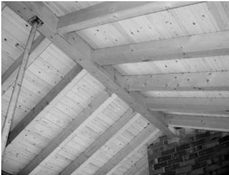
Correas que apoyan sobre una viga de cumbrera mediante un ensamble de cola de Milano Redondeada. La unión queda oculta y el resultado es muy limpio. Normalmente se deben disponer tirafondos oblicuos entre correa y viga como refuerzo en caso de incendio.
