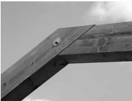
Enlace articulado en la clave de un pórtico de madera laminada encolada de pequeña luz. El encuentro entre las piezas se realiza a media madera y se cosen con un perno.
