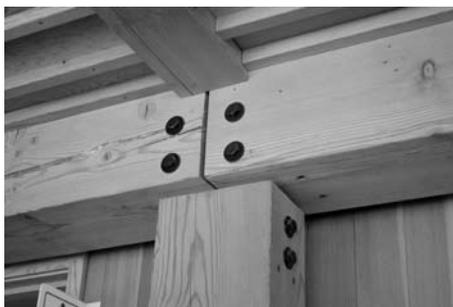
Encuentro entre dos vigas biapoyadas sobre la cabeza de un pilar. Todas las piezas son de madera maciza de gran escuadría. El enlace se realiza con un herraje de chapas de acero interiores que se alojan en las testas del pilar y de las vigas. Dos pernos afianzan cada conexión.
