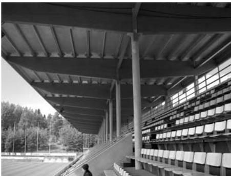
Apoyo de una viga de madera laminada de una cubierta en voladizo de un graderío sobre un pilar metálico de sección circular hueca. La chapa de testa del pilar sirve de zapata y aumenta la superficie de apoyo. Las pletinas laterales afianzan la unión y asumen los esfuerzos negativos debidos a la succión del viento.
