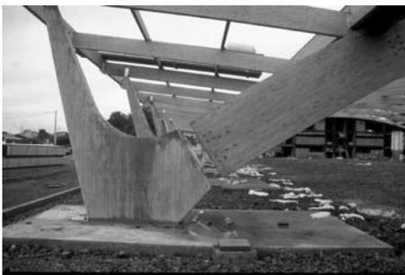
Apoyo articulado de un arco de 63 m de luz realizado con un herraje oculto. Una chapa interior se conecta a la madera mediante pernos. El resultado es limpio, su comportamiento al fuego mejor y aunque se trata de una estructura al interior, su exposición temporal a la lluvia durante el montaje no da problemas de manchas.
