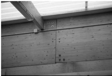
Empalme articulado de una viga continua (junta Gerber). El herraje es oculto y tiene forma de doble T con un alzado oblicuo. Las alas de la T descansan sobre la cara superior de la viga volada y abajo las alas de la T sirven de apoyo a la viga que viene del lado derecho.
