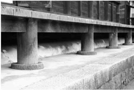
Pequeño poste que descansa sobre una basa de piedra que a su vez arranca de un basamento corrido. Queda alejado del contacto con el suelo y de la humedad. No obstante, presenta decoloración por las salpicaduras en la parte baja, pero se encuentra bien ventilado. Su reposición en caso de fuerte deterioro es sencilla.
