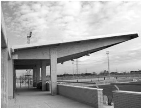
Cubierta en visera de un graderío. El pilar de madera laminada está compuesto por dos cordones y su apoyo en la base es una articulación que queda ligeramente separada del suelo. En encuentro con el dintel podría ser una articulación, pero también un enlace rígido.
