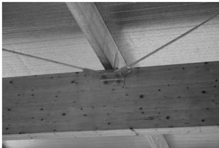
Apoyo de una correa continua sobre una viga. En este caso la correa apoya sobre la cara superior de la viga, lo que permite disponer vanos continuos de correas y el paso de instalaciones. En este caso el herraje del apoyo debe ser capaz de transmitir los esfuerzos de arriostamiento a la viga. También en la unión se observa un herraje para el anclaje de los tirantes de arriostamiento.
