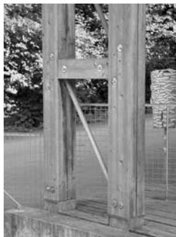
Cada cordón del pilar está formado por dos piezas de madera y en la base la conexión se realiza mediante una chapa de acero colocada en el interior de ambas piezas. La madera queda también separada del nivel del solado.
