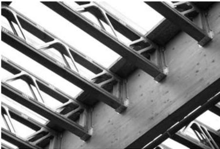
Apoyo de correas mixtas de madera y alma metálica para naves industriales. El apoyo en la viga se realiza mediante herrajes clavados.
