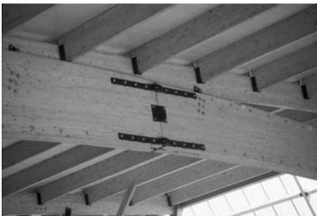
Junta de transporte en un pórtico. Se trata de un empalme con capacidad de transmisión de momentos flectores (semirrígido) que transmite la tracción y compresión con las chapas metálicas de los extremos de la sección y con un herraje central para el cortante. La sección mantiene su libertad para la merma debida a la pérdida de humedad.
