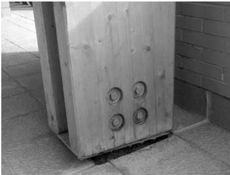
La estabilidad de la estructura, considerando el apoyo articulado de la base del pilar, queda garantizada por el encuentro articulado del dintel en la estructura de hormigón.
