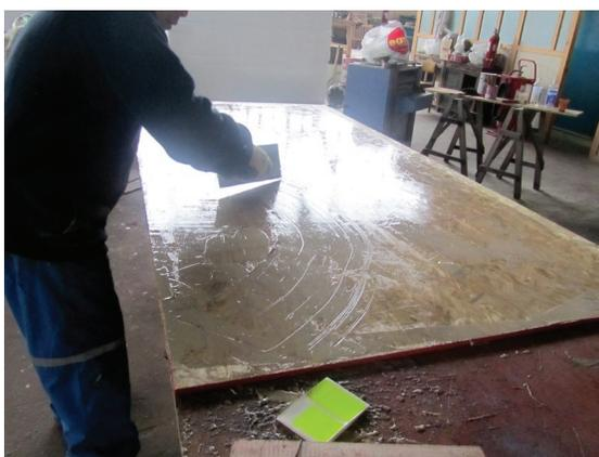
Figura 7a Encolado de paneles OSB
