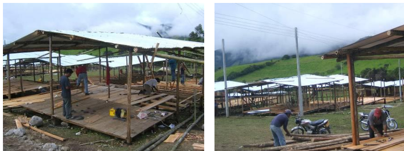
Construcción de Albergues Temporales, Departamento del Nariño, Colombia.
