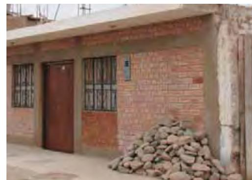
de marco a la puerta de ingreso y que suben al segundo piso. Los dinteles sobre cada vano, en lugar de tener un empotramiento de 0.30 m en cada lado, como es la práctica común, corren a todo lo largo de la fachada. Las varillas de acero sobresalen por encima del techo con una longitud adecuada para empalmar con las varillas de las columnas del segundo piso.
