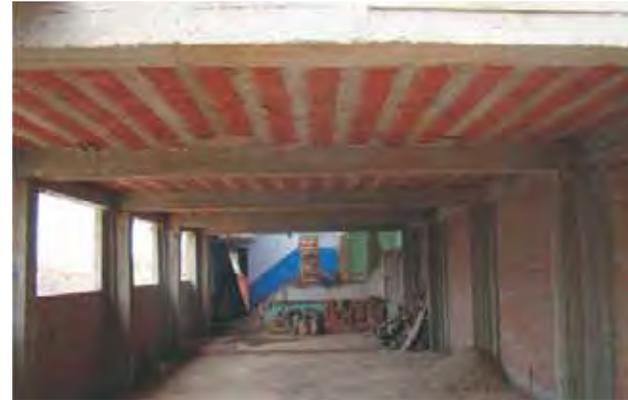
>>**Fig.11.2** Edificio de concreto armado con columnas en forma de T en la fachada y con gran resistencia al corte. No sufrió daños.
