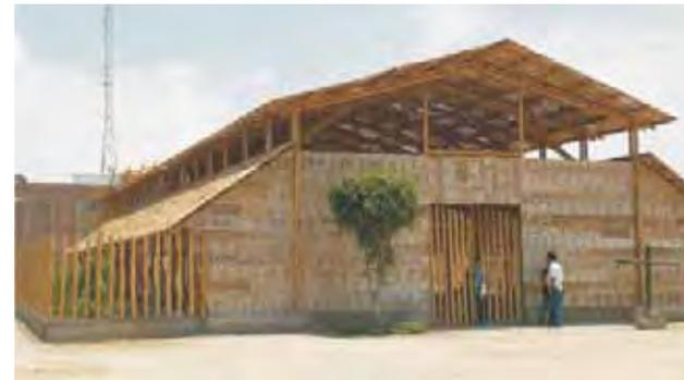
>>**Fig. 11.3** Iglesia de La Compañía de Jesús, en Pisco, en proceso de construcción con bambú, material liviano, flexible y de gran resistencia sísmica.
